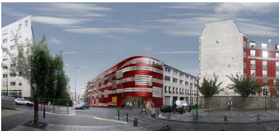
91/95 rue de la fontaine au roi – architecte Agence Metra & associés /Terrel International
